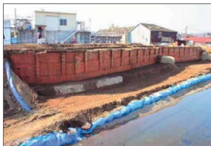
文化財調査によって出現した大正時代に造られたレンガ護岸
